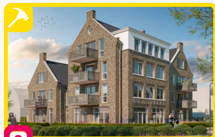
2 Hoek Julianastraat- Langewijk Acht appartementen en één kantoor voor zakelijke dienstverlening.
